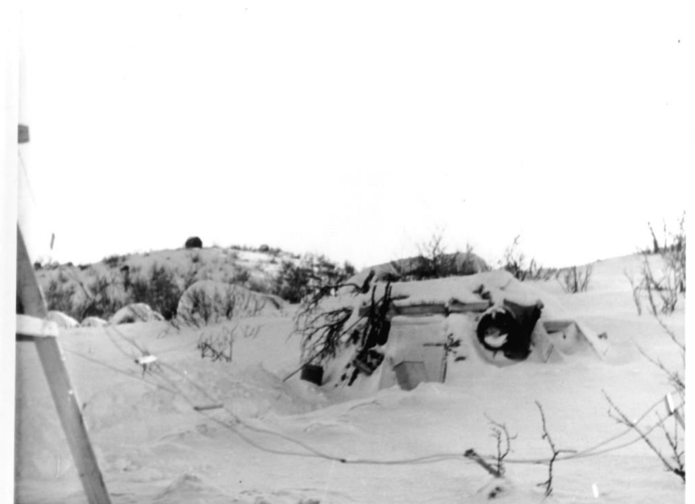
Fotografiet viser aggregatbua og deler av 600 Ohms transmisjonslinje. Foto: Hans Petter Faye-Thilesen 1943 – 44.
