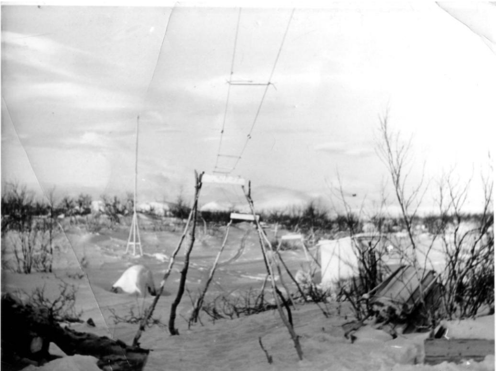
Fotografiet viser 600 Ohms transmisjonslinje og en del av dipolantennen. Bua til høyre for transmisjonslinjen er WC. Foto: Hans Petter Faye-Thilesen 1943 – 44.
